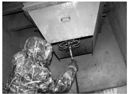
30 мая промывка мусоропроводов проводилась в доме № 32 на ул. Индустриальной
